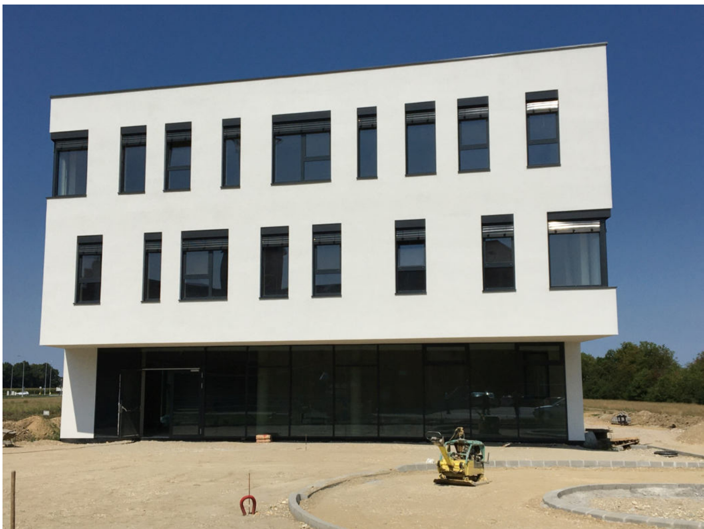
Baustelle Schulgebäude: Außenanlage und Zugänge werden vorbereitet
