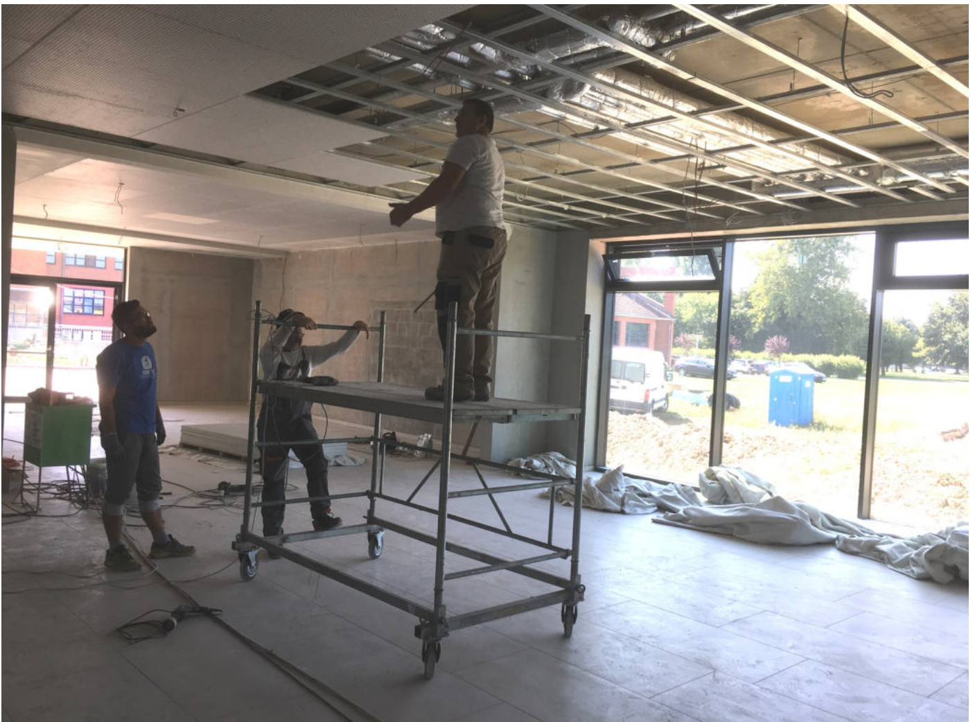
Innenausbau—die Decken werden in Eigenleistung verbaut
