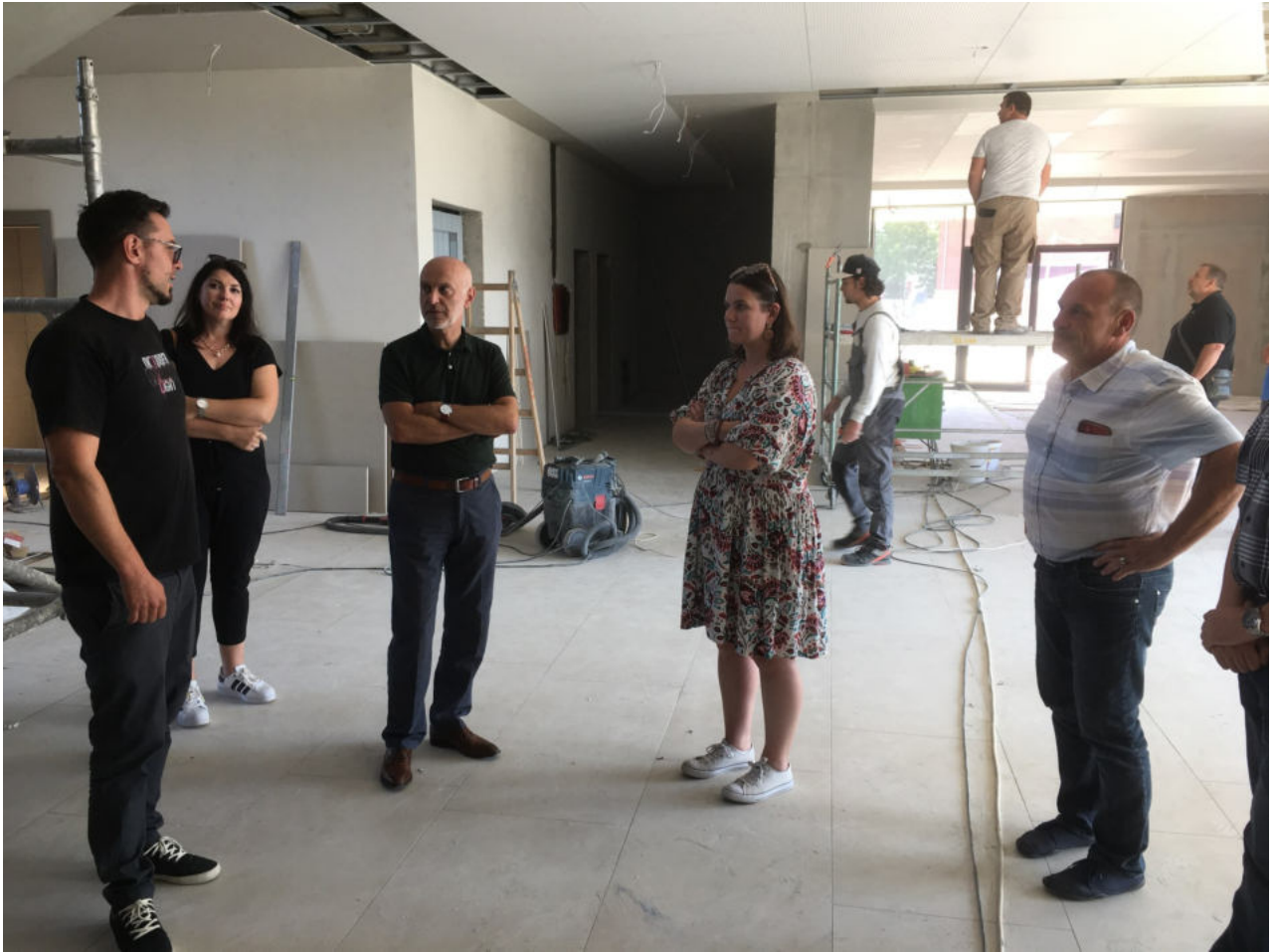
Besichtigung im Eingangsbereich des neuen Schulgebäudes
